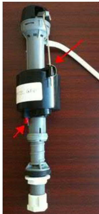
Comment régler le niveau d'eau du réservoir (Figure 2)
