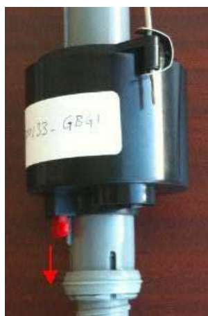
Tirez vers le bas l'écrou de blocage rouge (Figure 3)
